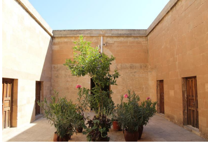
Foto 4: Şehitlik (Necmeddin-Asfar Camisi) Avludan
